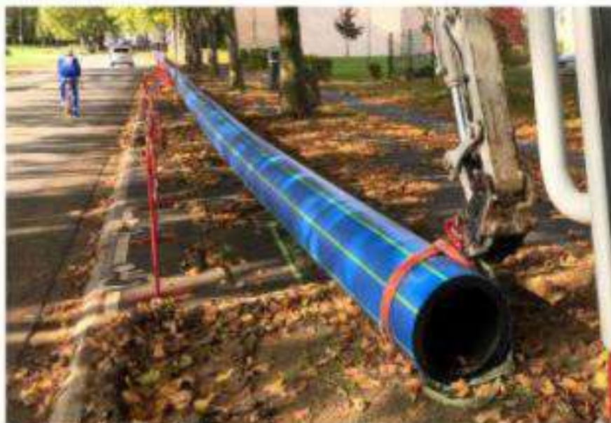
En attendant d'être enterré à 10 mètres de profondeur, les cylindres sont assemblés le long du boulevard Camille-Gaëtan.
